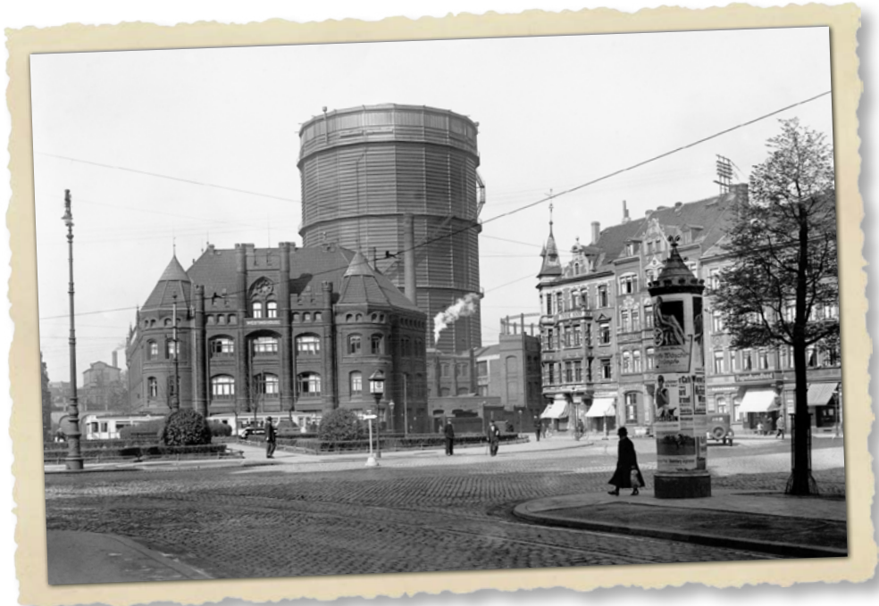
Das Verwaltungsgebäude am Goetheplatz in den 30er Jahren.
